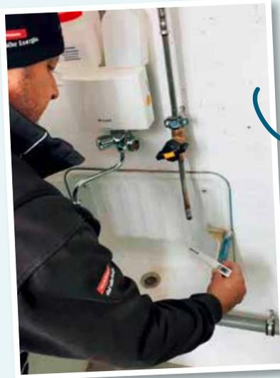
Im Anschluss wird die Temperatur des Wassers gemessen.
