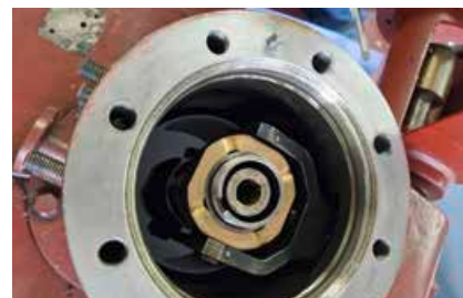
Einblicke, die sonst nicht möglich sind: Der Generator wird ausgebaut.
