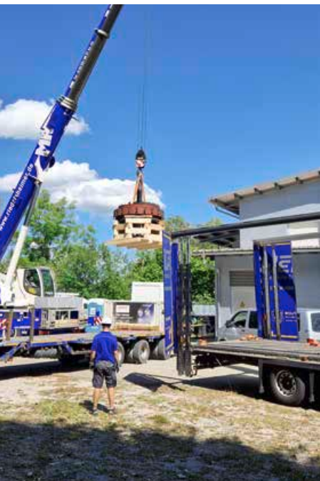
Erst Ausbau, dann Transport: Der Generator geht auf die Reise.
