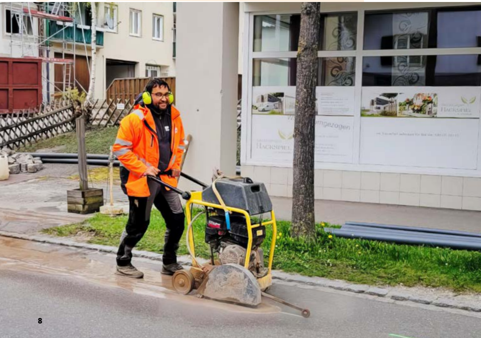
Während vorne die Straße für den Netzausbau geöffnet wird ...
